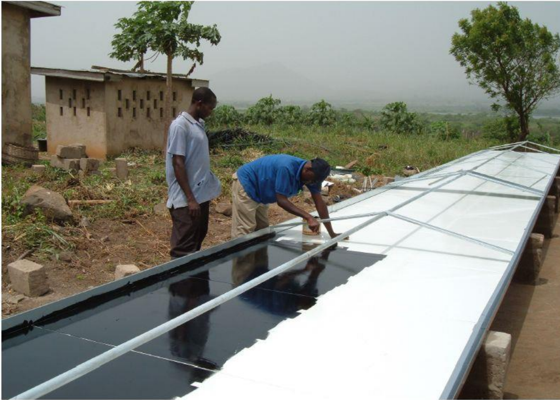
Figura 7: Secador Hohenheim, Ghana. El colector esta siendo pintado con pintura negra. Foto: Tony Swetman
