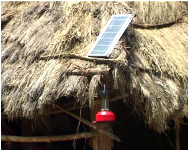
Figura 1: Panel fotovoltaico usado para iluminación solar en una población rural en Nepal. Foto de: Practical Action.
