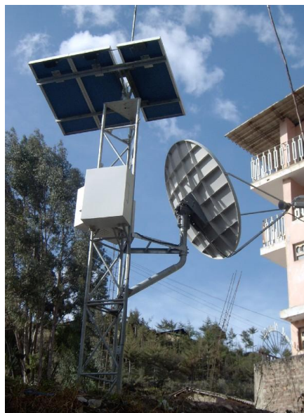
Figura 3: La Encanada infocentre, Perú. Dispone de paneles solares para generar electricidad y un satélite para telecomunicaciones. Foto: Practical Action / Jaime Soto.
