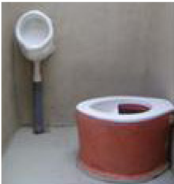
Urinario de fibra de vidrio y eco-inodoro instalados dentro de la caseta de un baño ecológico seco
