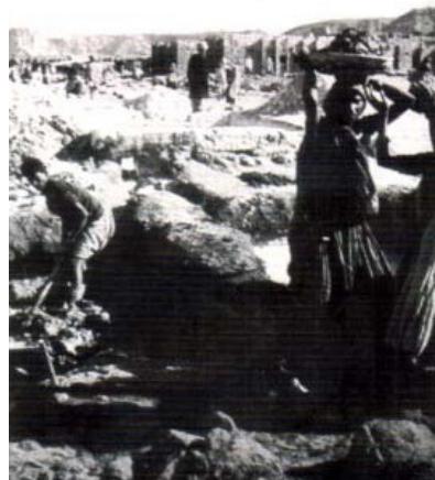
Extracción de arcilla en la India para ser usada como puzolana. La arcilla es quemada y mezclada con cal para producir mezclas para enlucidos y morteros.
