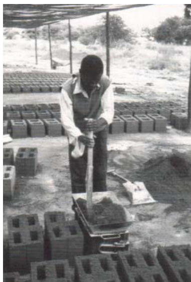
Producción manual de bloques de puzolana y cemento Portland
