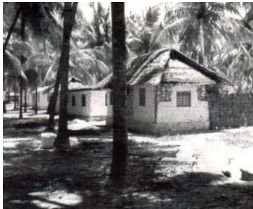
Construcción de una vivienda tradicional en Zanzíbar, usando cal, a base de coral, como cemento en pisos y muros.
